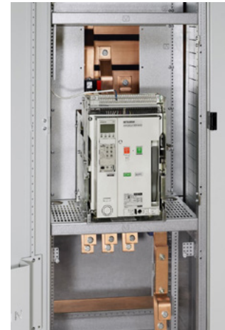
Colonne d'alimentation avec disjoncteur
